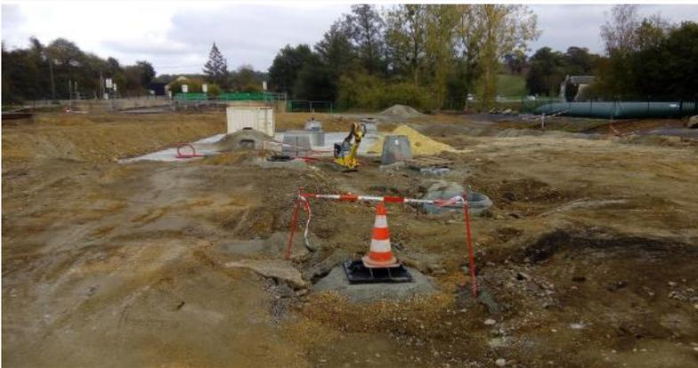
Si les travaux préparatoires, les déblais, la mise en œuvre des réseaux de gestion des eaux de voirie, le démantèlement du local de pesée ainsi que de l'ancien pont-bascule, se sont déroulés dans un délai conforme au planning de réalisation, les problèmes liés à la portance des travaux de gros œuvres (dalles béton) ainsi que des voiries lourdes et légères générés un retard important sur le déroulé du programme initial prévu par la maîtrise d'œuvre.
